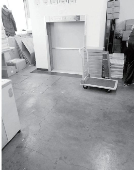
【エレベーター】
